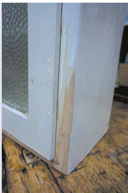
4. Warstwy starej farby olejnej z gruntem.
