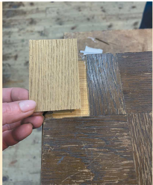
12. Wstawka z dębowej okleiny gotowa do wklejenia.
