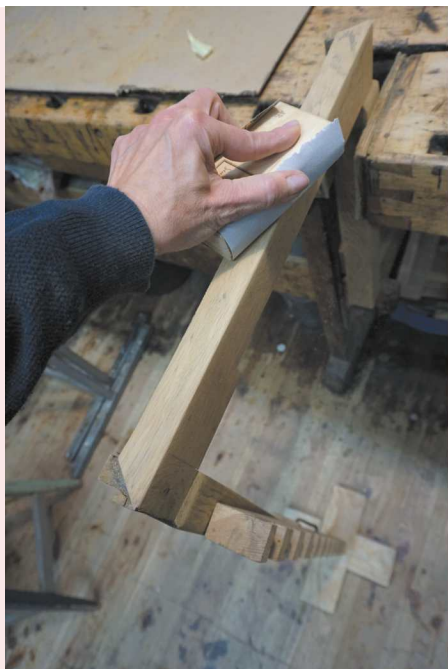
1. Usuwanie starej powłoki przy pomocy papieru ściernego umieszczonego na kostce szlifierskiej.
